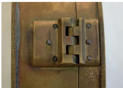
Abb. 13: Gehäusescharnier Typ 20.
