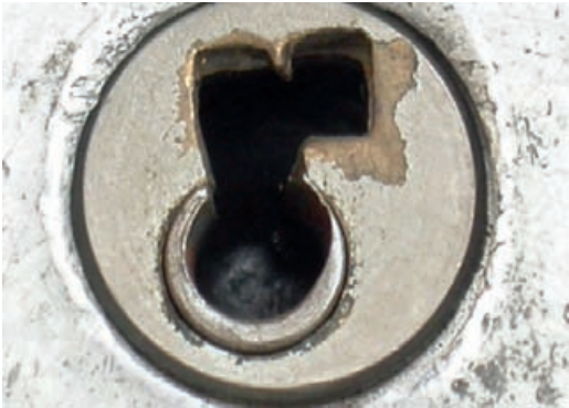
Abb. 15: Öffnung für Markierschlüssel Typ 49.
